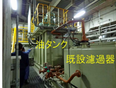
↑主機 油タンクのとりに 油濾過器が置かれています
